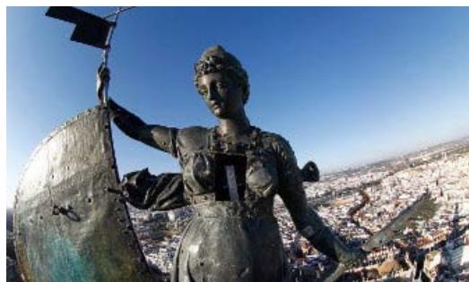
Imagen del Giraldillo estos días, con la tapa de registro del pecho completamente abierta para permitir la inspección del vástago interno. / A. Pizarro
