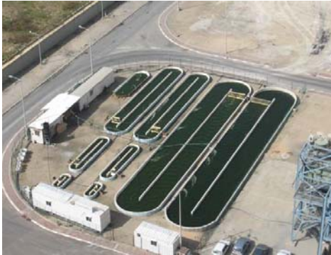
Figura 3. Una industria sostenible. La empresa israelí Seabiotic tiene en uso una planta piloto para el consumo de CO 2 procedente directamente de las chimeneas de una fábrica de electricidad de la Israeli Electric Company . El alga, del género Nannochloropsis , produce un 30% de lípidos por gramo de biomasa y se emplea para la producción de biodiesel. La fotografía muestra como el gas carbónico sale de la industria por un conducto (esquina inferior derecha) que está conectado directamente a los biorreactores abiertos de agua salada donde crece el alga, que se recoge posteriormente para su procesamiento. Imagen cedida por Ami Ben-Amotz .
